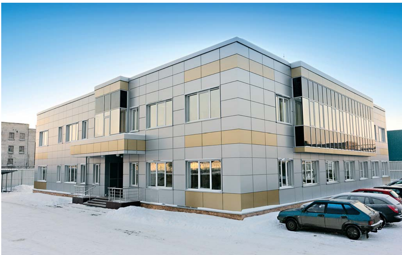
Центральный офис ЗАО «ВИНГС-М», г.Балашиха Московской области
